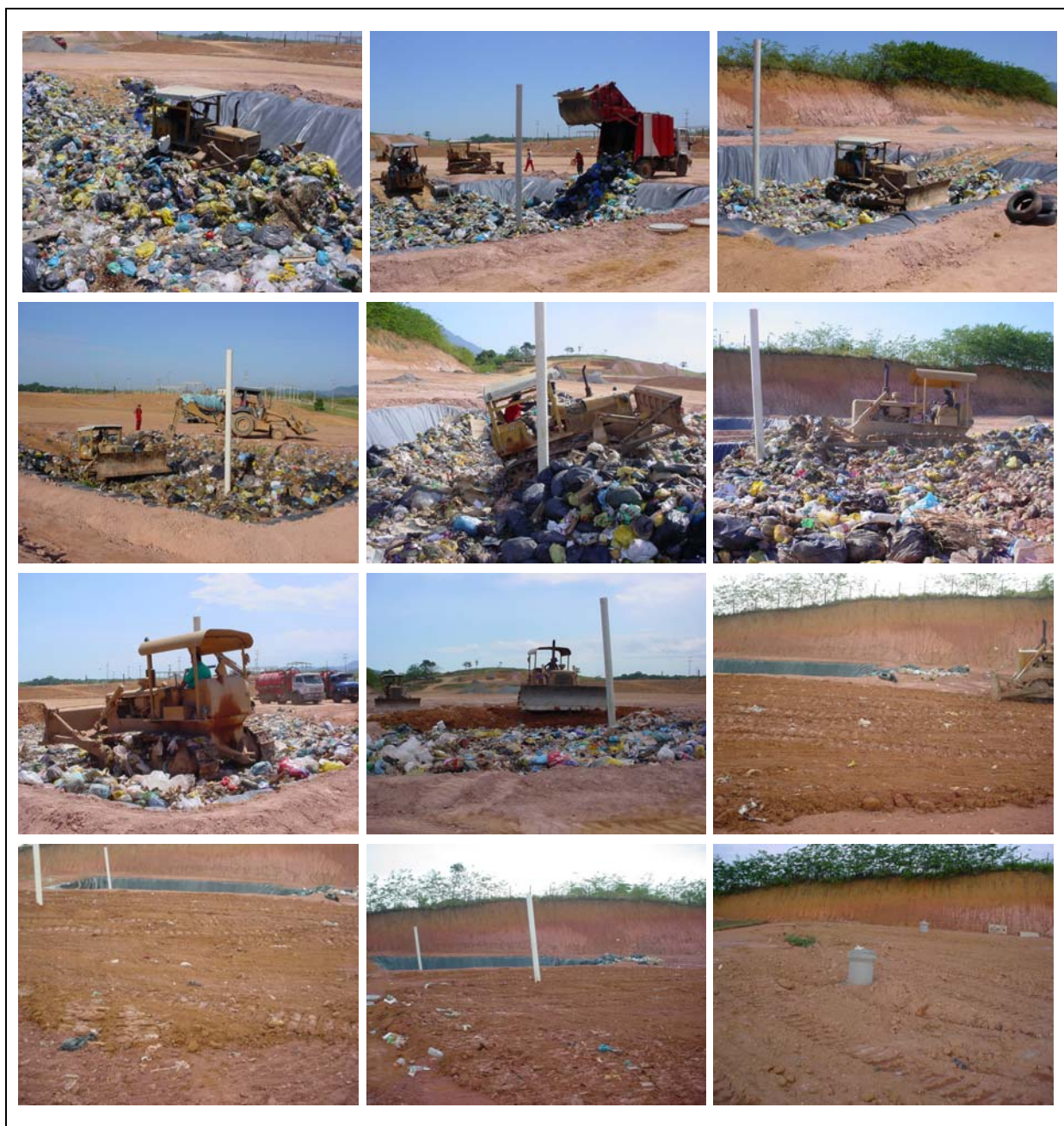
Fig.3.25 – Processo de enchimento e fechamento da célula
