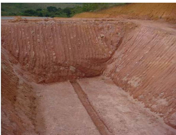
Fig. 3.14 – Dreno de monitoramento
