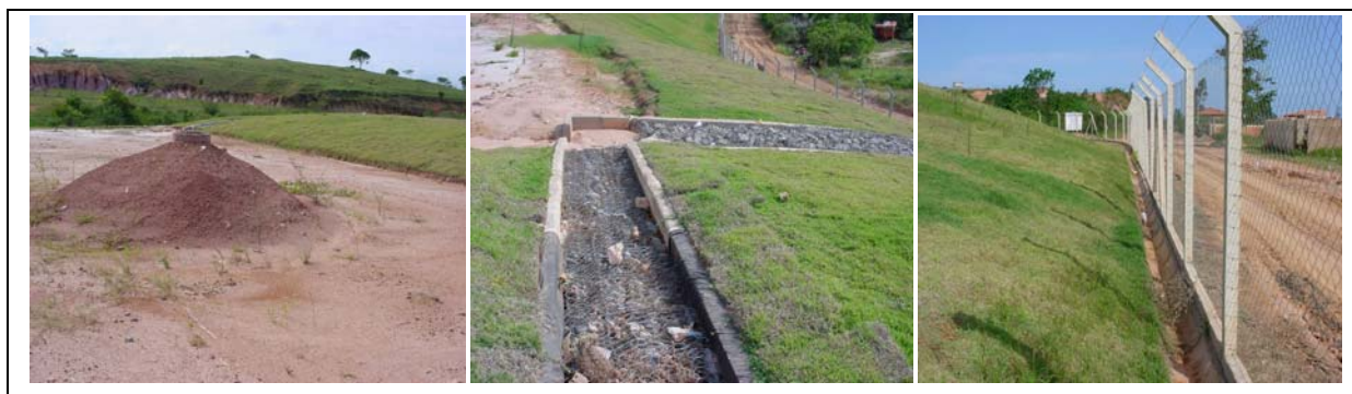
Fig. 3.5 – Detalhe das construções efetuadas na recuperação do lixão (dreno de gás, canal de escoamento pluvial, canaleta de águas superficiais)
