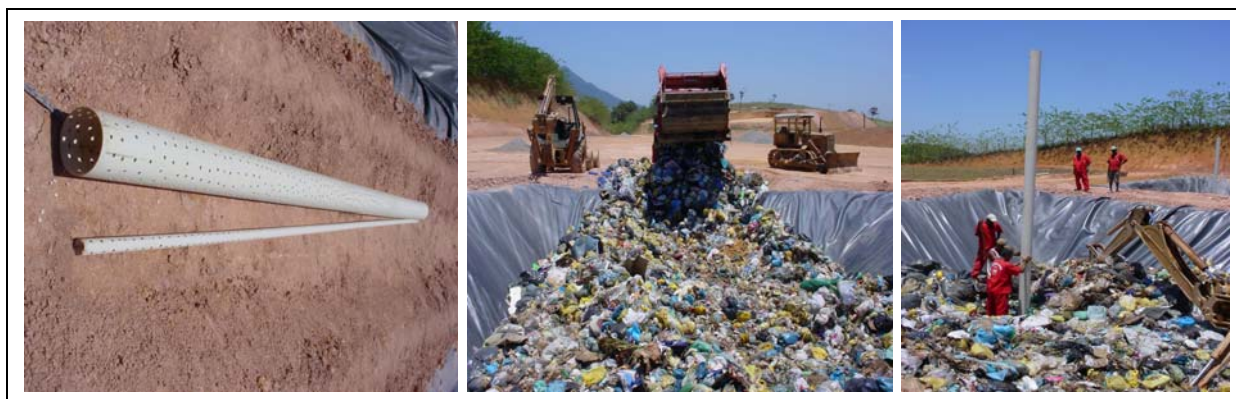
Fig. 3.24 – Dreno de gás e sua fixação
