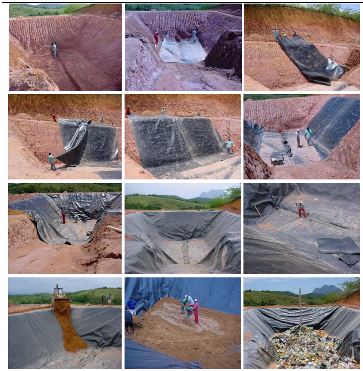
Fig. 3.17 – Seqüência de impermeabilização da CISC
