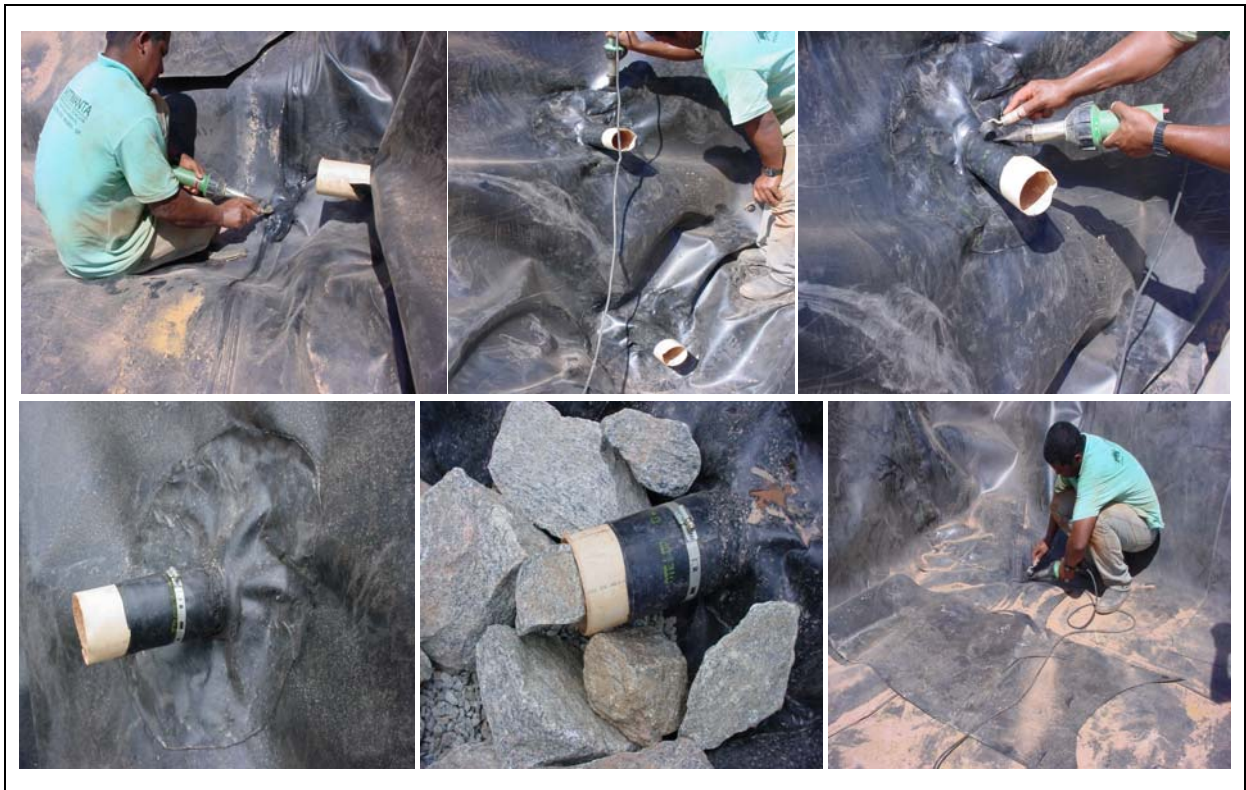
Figura 3.20 – Detalhes da impermeabilização
