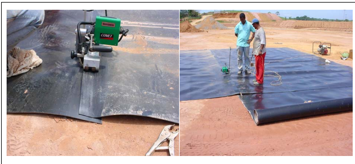
Fig. 3.19 – Soldagem da manta
