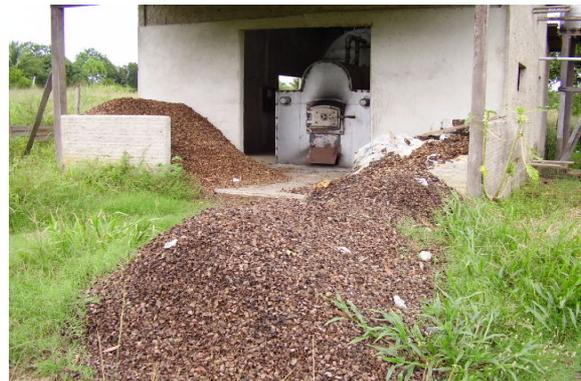
**Figura 19.** Foto da caldeira da fábrica da COMAJA e vista dos montes de cascas de castanha dispostas, que serão utilizadas para geração de vapor, utilizado na fábrica.
