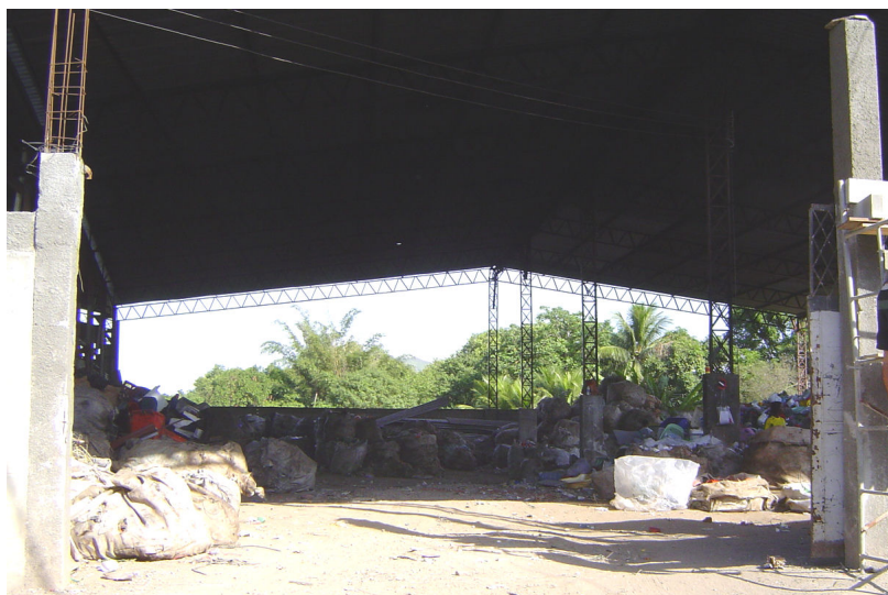
FIGURA 26- Galpão de resíduos recicláveis.
