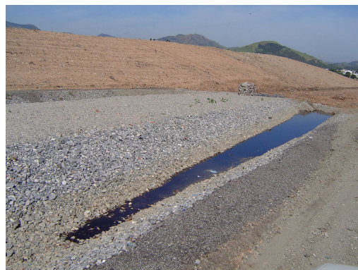
Figura 24- Infiltração de chorume com a galhada
