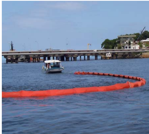
Figura 2.3 - Operação com barreira de contenção no mar. Fonte: Arquivo Caravana da Cidadania.
