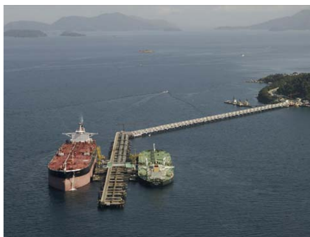
Figura 4.9 - Píer do Terminal Aquaviário de Angra dos Reis. Fonte: Arquivo Tebig.
