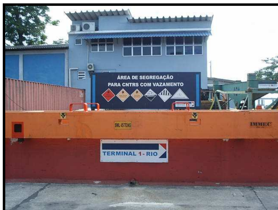
Figura 4.4 - Tanque para armazenamento de contêineres com vazamentos
