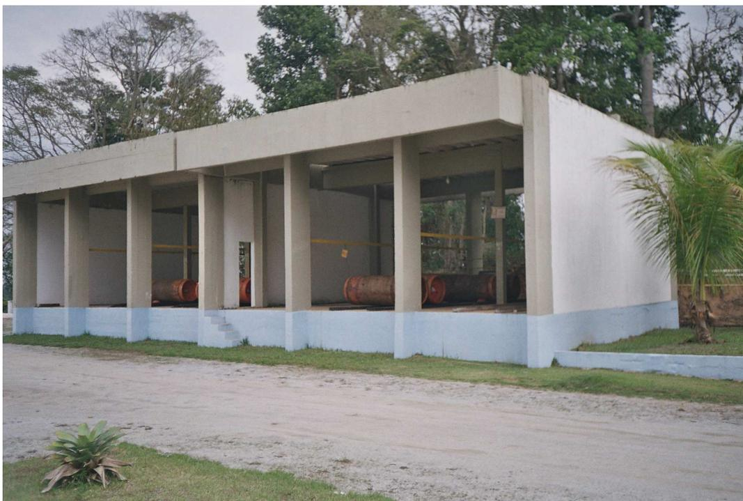
**Figura 10. Setor de cloro e a plataforma de desembarque de cilindros.**
