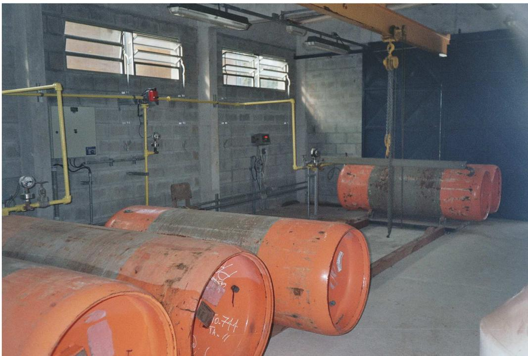
**Figura 16. Setor de cloro. Em primeiro plano, os cilindros.**
