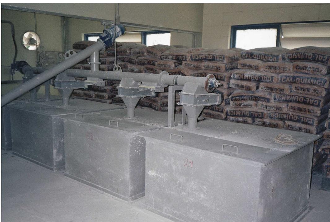
**Figura 41. Sistema de transporte de cal, silos e fardos na Casa de Química.**
