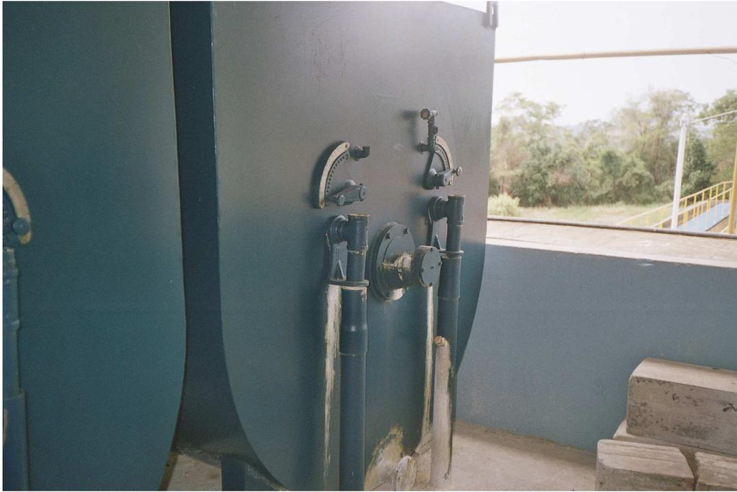
**Figura 36. Dosadores de solução de cal hidratada.**
