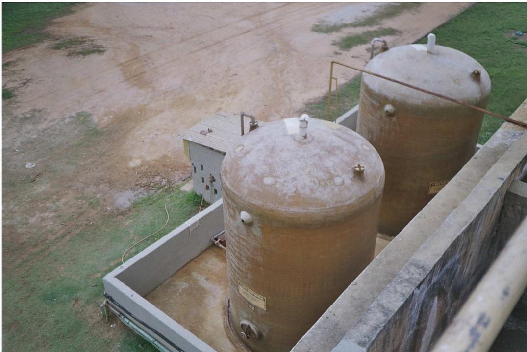
**Figura 8. Silos de sulfato de alumínio na ETA da Conc. Alfa**
