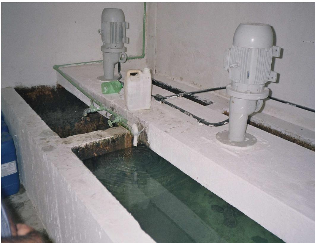
**Figura 38. Tanques de diluição de polímero.**
