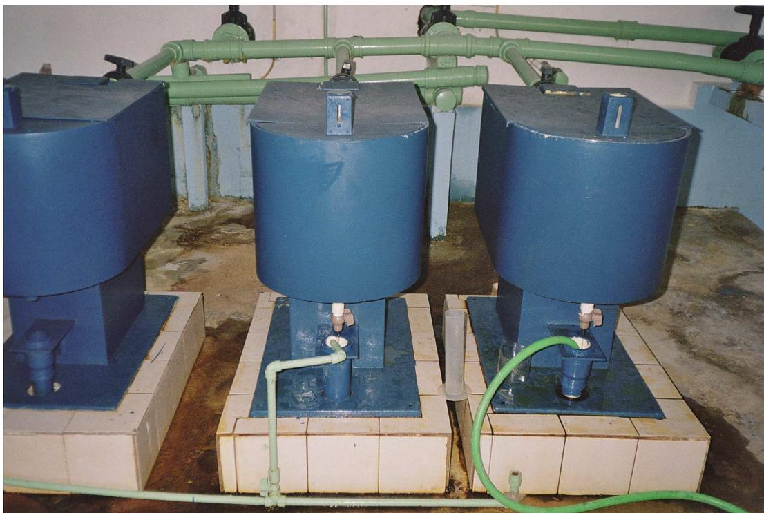
**Figura 9. Dosadores de sulfato de alumínio.**
