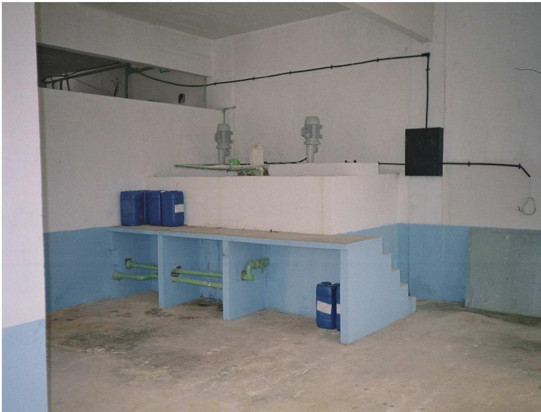
**Figura 37. Tanques de diluição de polímero, com bombonas do produto.**
