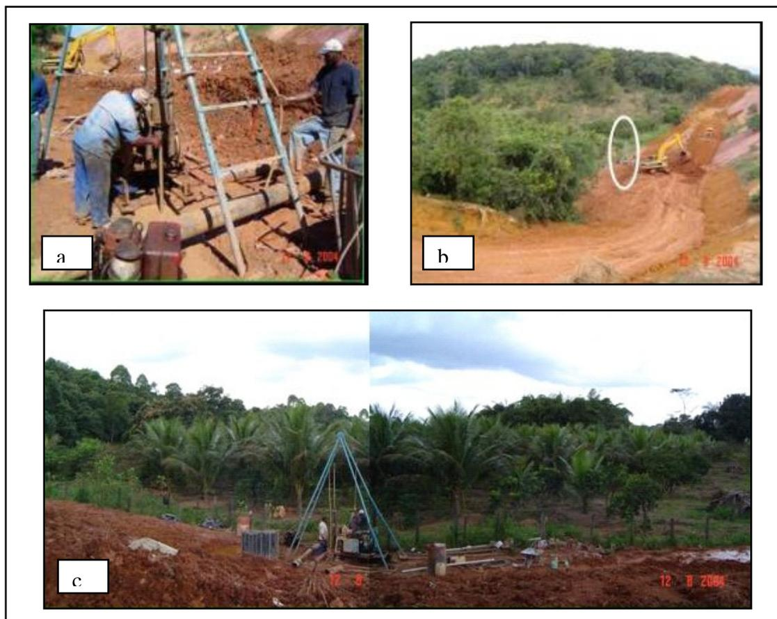
Figura 5.3. a) Detalhe da instalação do PZ2; b) vista geral da localização do piezômetro; c) proximidade com os coqueiros do sítio vizinho. Fonte: Mattos, 2005.
