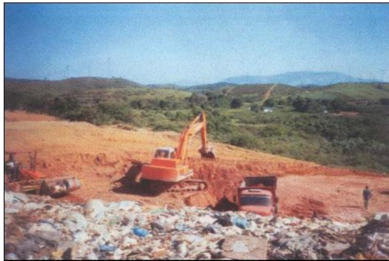
**Figura 4.9. Execução dos drenos de chorume.** Fonte: ENLURB, 2003.
