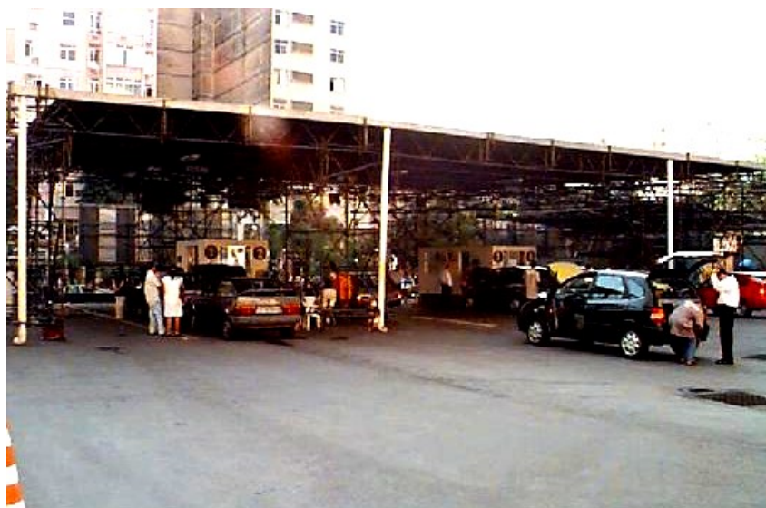
Figura 4.1.3 – Posto de Troca de Placas com Cobertura Contínua (1997)
