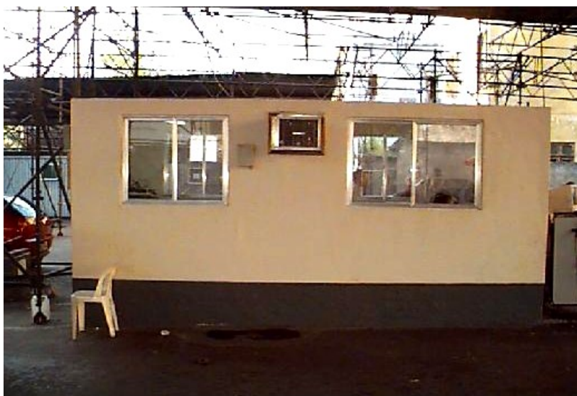
Figura 4.1.4. – Cabine de Posto de Troca em Alvenaria (1997).
