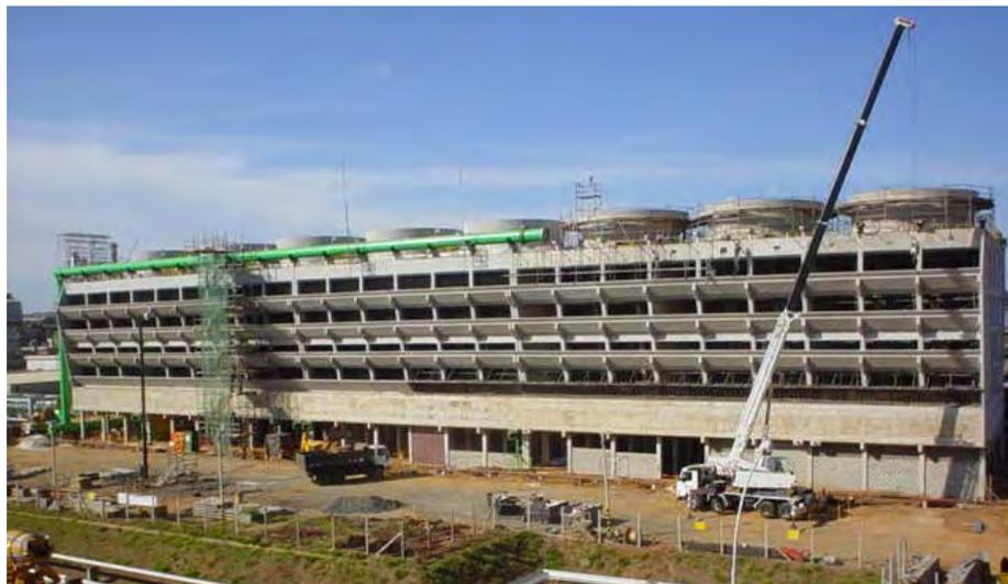
**Figura 2.12b: Torre com tiragem mecânica induzida em corrente cruzada**
