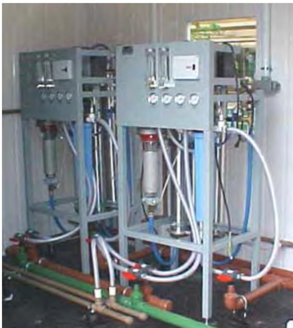
**Figura 4.6a: Sistema de Reuso de Água – Ultrafiltração**
