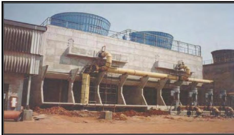
**Figura 2.13b: Torre com tiragem mecânica induzida em contracorrente**
