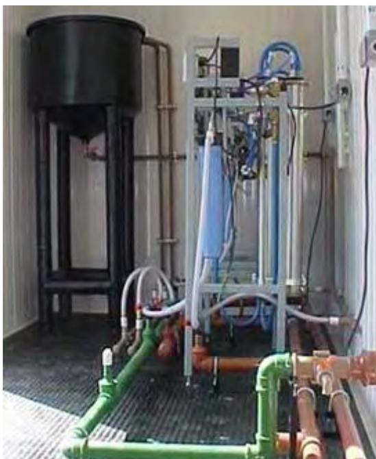
**Figura 4.6b: Sistema de Reuso de Água – Membranas de Ultrafiltração**
