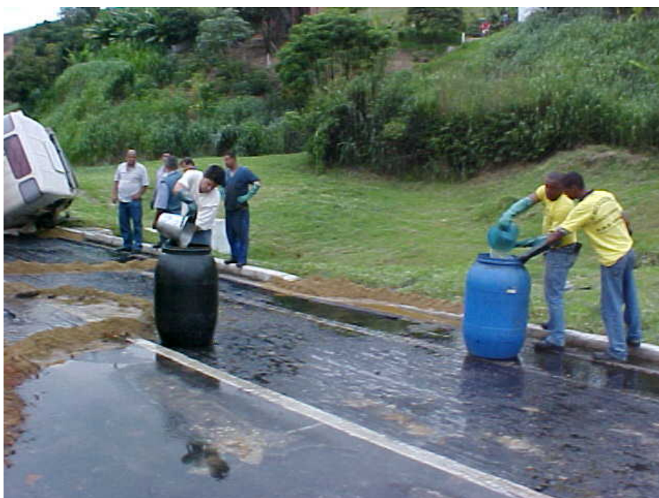
Figura 6: Acidente com álcool anidro – Recolhimento manual do resíduo, para destino final (Fonte e Autoria: FEEMA / SCPA – Alberto Andrade Cruz)
