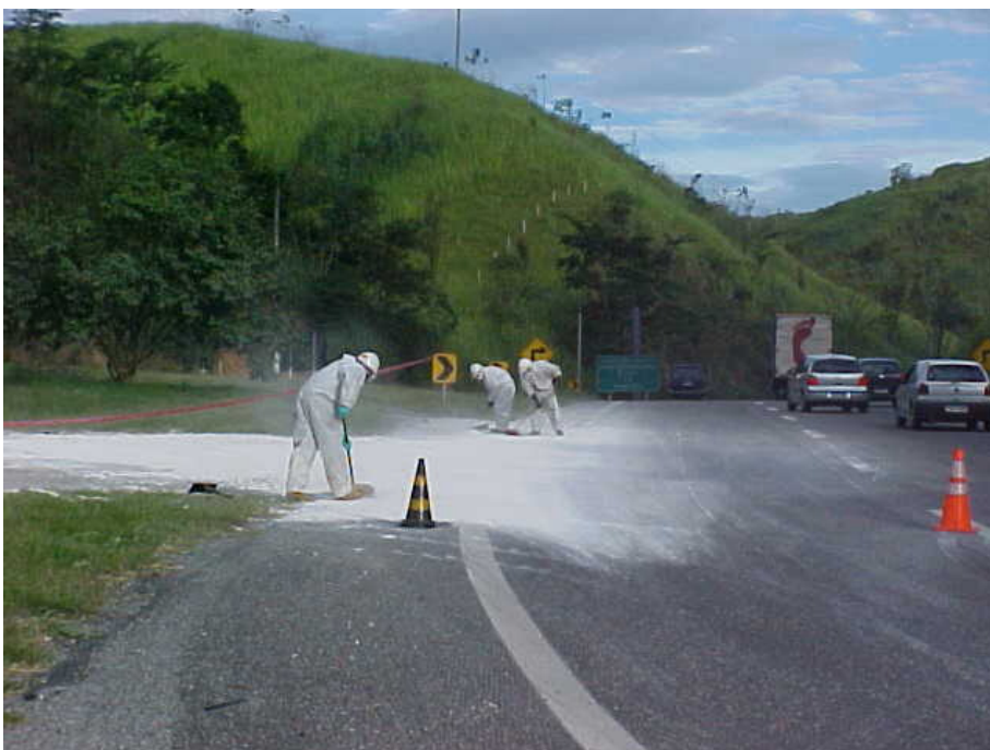
Figura 13: Acidente com óxido de cálcio (cal). Fase de limpeza manual, por equipe técnica, da área contaminada. (Fonte e Autoria: FEEMA / SCPA – Américo Dutra Almeida).
