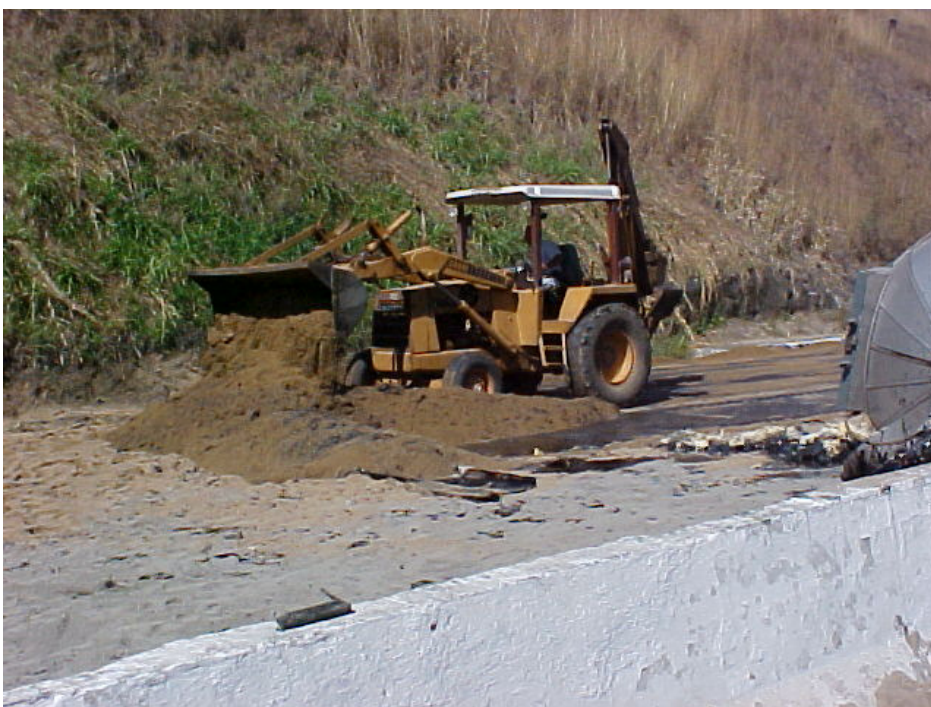
Figura 36: Acidente com óleo BPF- Limpeza mecânica da pista, usando areia dos diques como meio absorvente. (Fonte e autoria: FEEMA/SCPA - Carlos Eduardo Strauch.)
