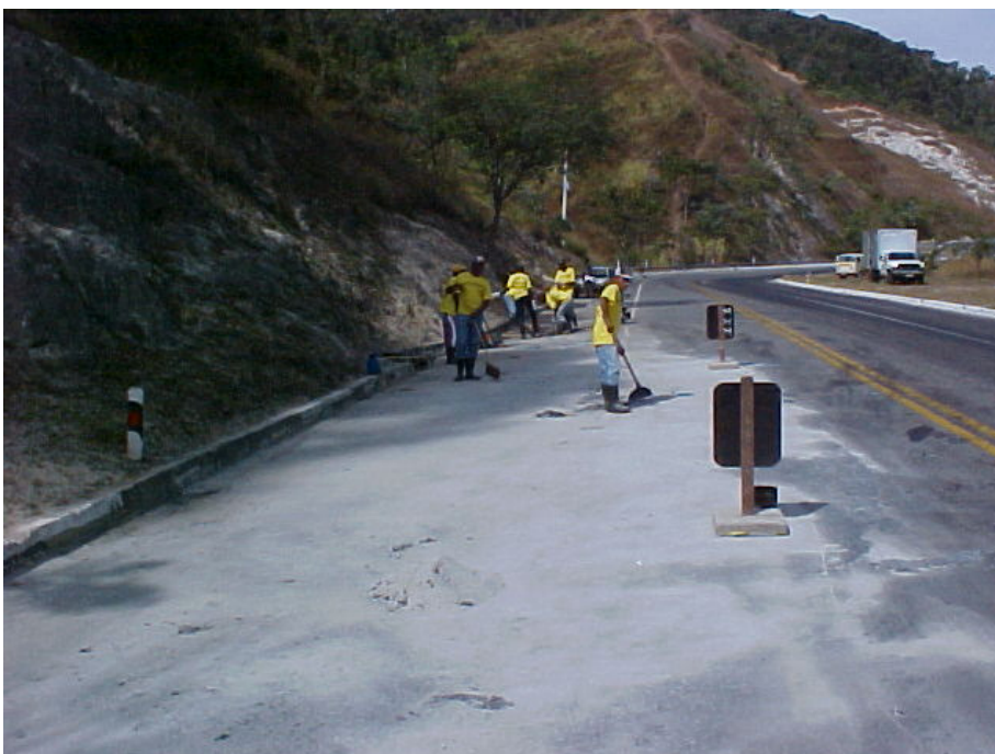
Figura 44: Acidente com óleo BPF- Fase final de limpeza (pente fino, polimento). (Fonte e autoria: FEEMA/SCPA - Carlos Eduardo Strauch.)
