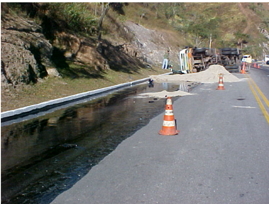
Figura 29: Acidente com óleo BPF- Vista da pista interditada, contaminada pelo óleo e da colocação de diques de contenção (Fonte e autoria: FEEMA/SCPA - Carlos Eduardo Strauch).
