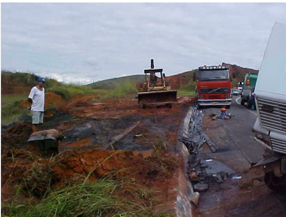
Figura 19: Acidente com concentrado de chumbo - Fase de limpeza / descontaminação do solo por raspagem mecânica. (Fonte e autoria: FEEMA/SCPA - Carlos Eduardo Strauch.)
