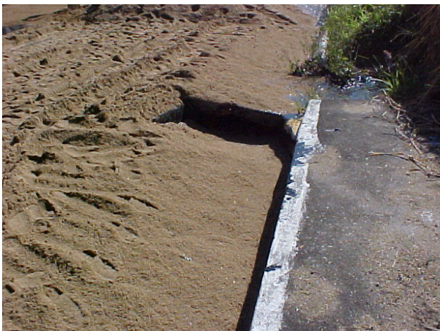
Figura 39: Acidente com óleo BPF- Derramamento atingindo a boca de lobo (sistema de drenagem) da via. (Fonte e autoria: FEEMA/SCPA - Carlos Eduardo Strauch.)
