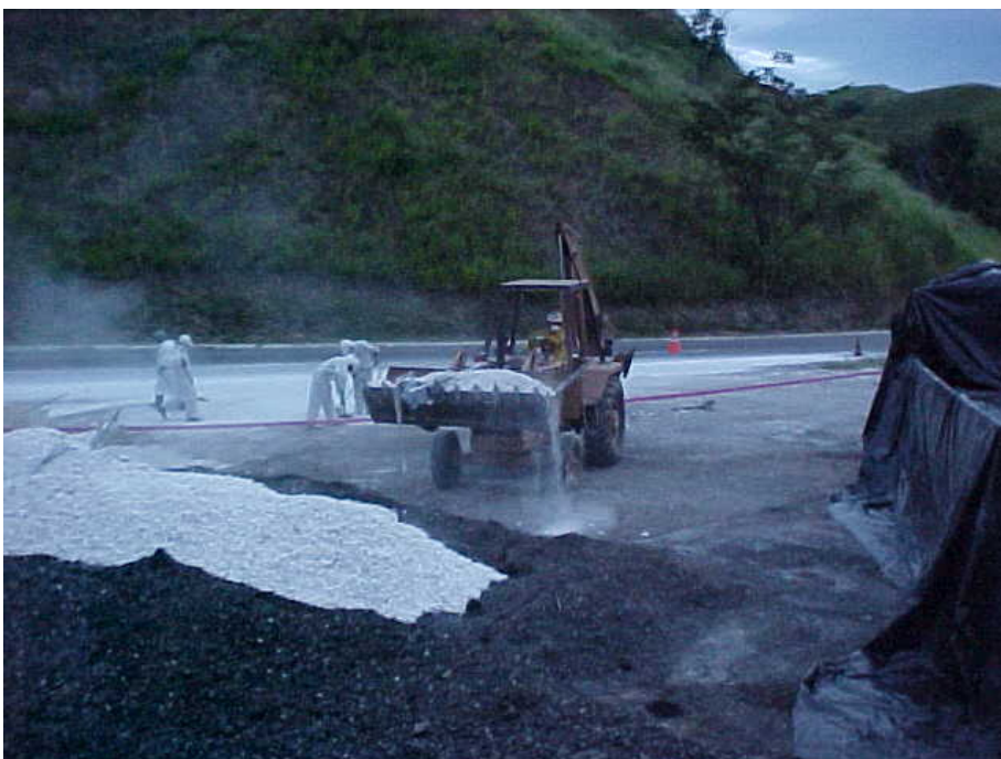
Figura 14: Acidente com óxido de cálcio (cal) - Fase de limpeza mecânica, recolhimento e destino final do resíduo. (Fonte e Autoria: FEEMA / SCPA – Américo Dutra Almeida).
