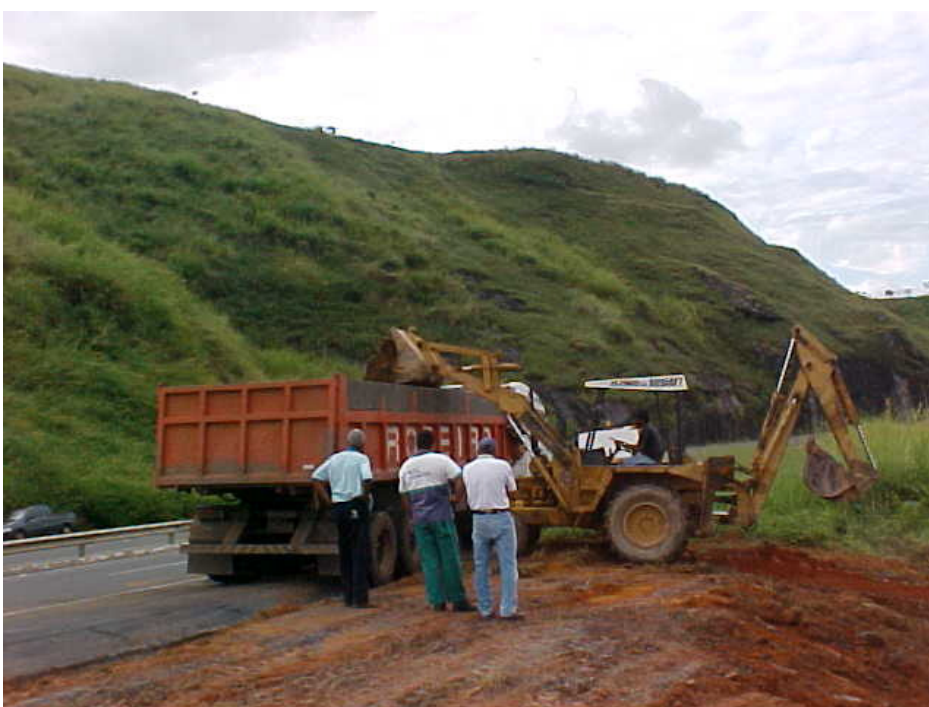
Figura 20: Acidente com concentrado de chumbo - Fase de limpeza, retirada e destinação do resíduo gerado. (Fonte e autoria: FEEMA/SCPA - Carlos Eduardo Strauch.)
