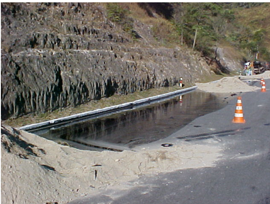
Figura 30: Acidente com óleo BPF- Sistema de diques de contenção com areia. (Fonte e autoria: FEEMA/SCPA - Carlos Eduardo Strauch.)
