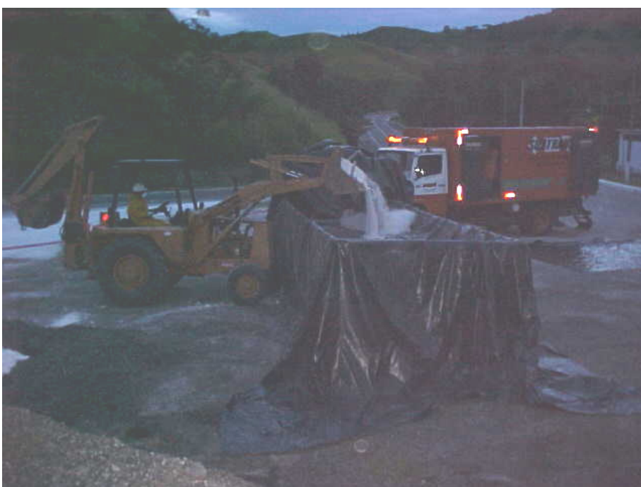
Figura 16: Acidente com óxido de cálcio (cal) - Recolhimento do resíduo em caminhão basculante lonado. (Fonte e Autoria: FEEMA / SCPA – Américo Dutra Almeida.)
