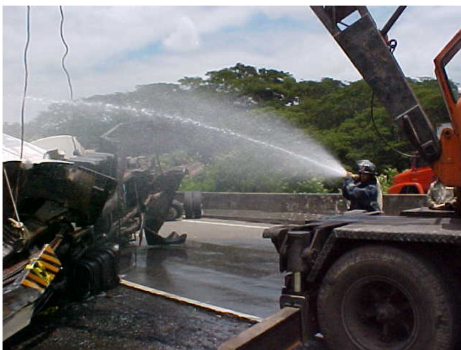
Figura 8: Acidente com álcool anidro – Fase de destombamento com aplicação de água em forma de neblina (Fonte e Autoria: FEEMA / SCPA – Alberto Andrade Cruz)
