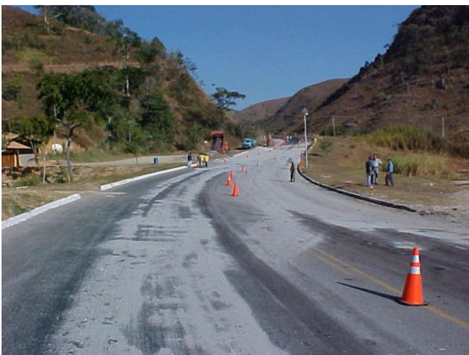
Figuras 28: Acidente com óleo BPF- Área da rodovia contaminada pelo derramamento. (Fonte e autoria: FEEMA/SCPA - Carlos Eduardo Strauch.)
