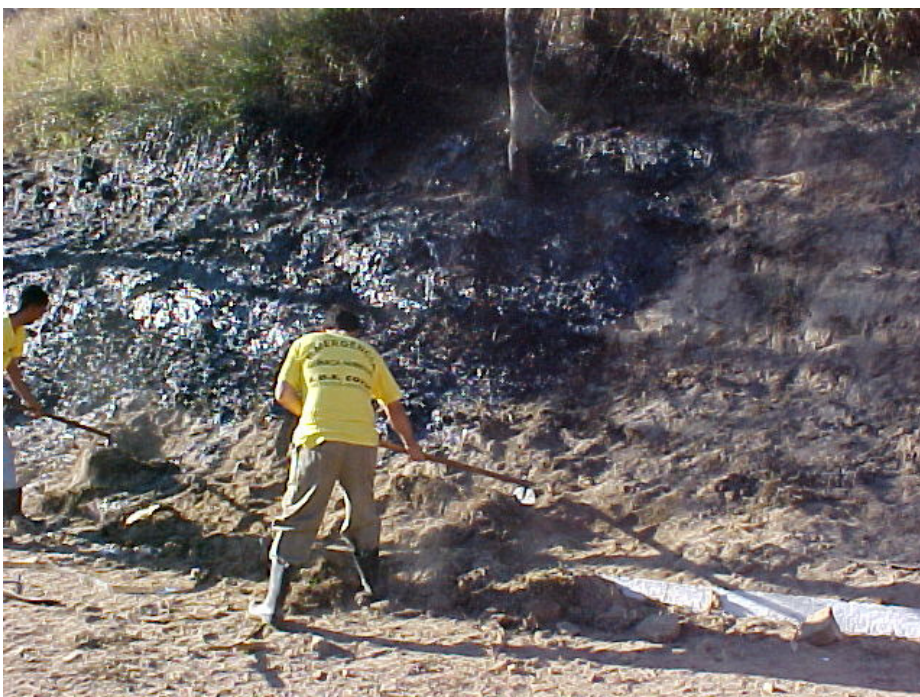
Figura 35: Acidente com óleo BPF- Limpeza manual do talude contaminado pelo óleo. (Fonte e autoria: FEEMA/SCPA - Carlos Eduardo Strauch.)
