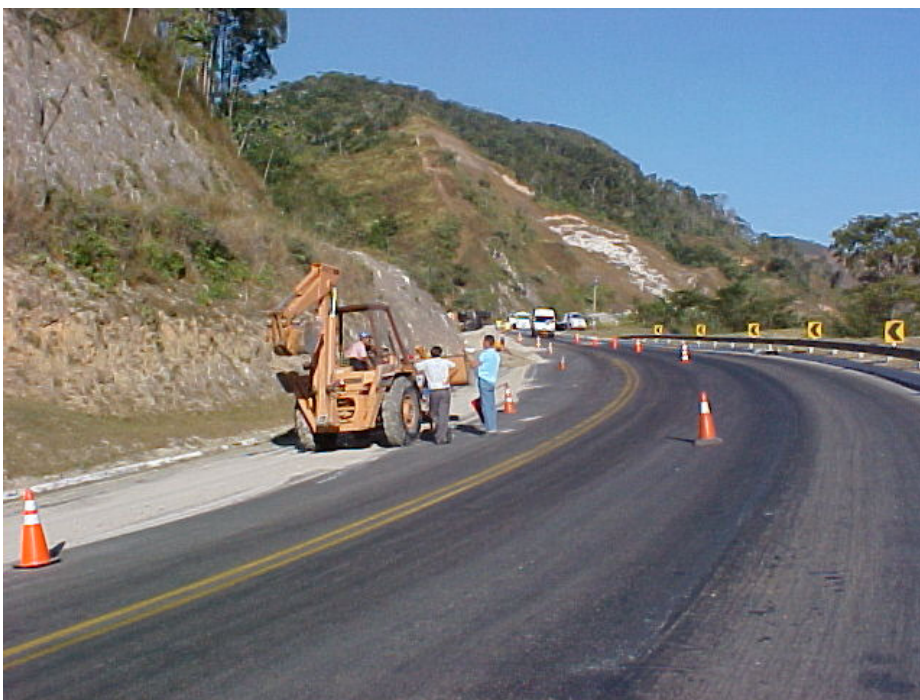
Figuras 27: Acidente com óleo BPF- Área da rodovia contaminada pelo derramamento. (Fonte e autoria: FEEMA/SCPA - Carlos Eduardo Strauch.)
