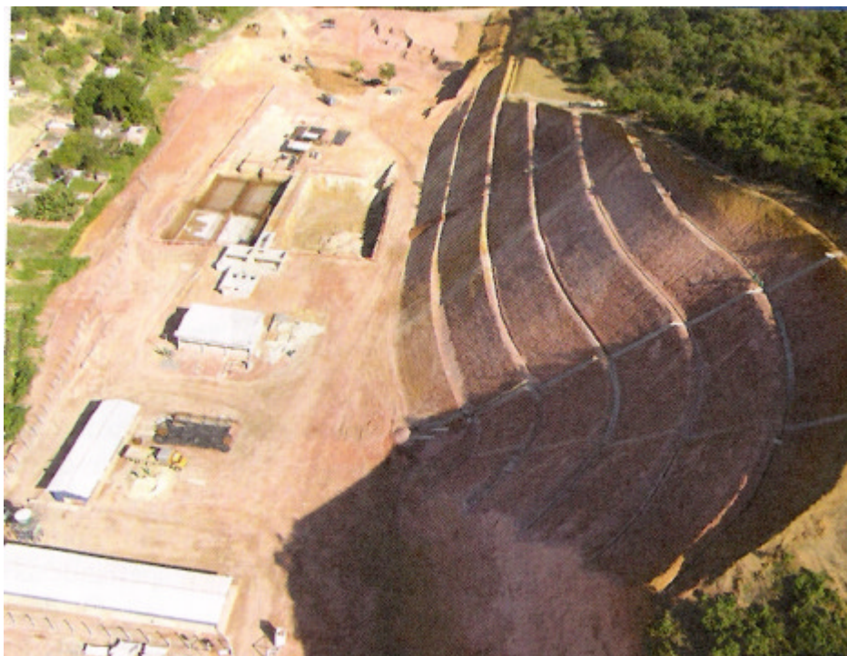
Figura 3.19 - Estação de Tratamento de Esgoto de Heliópolis
