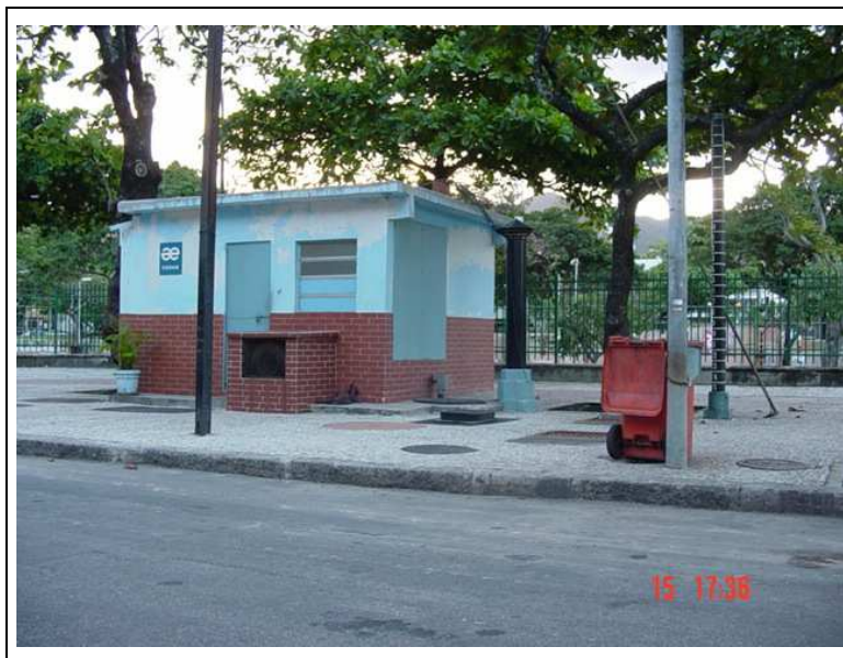
Figura 3.4. Vista da Casa de Operação e da Régua de Controle do Poço de Sucção da Elevatória Caiçaras – EE-13.
