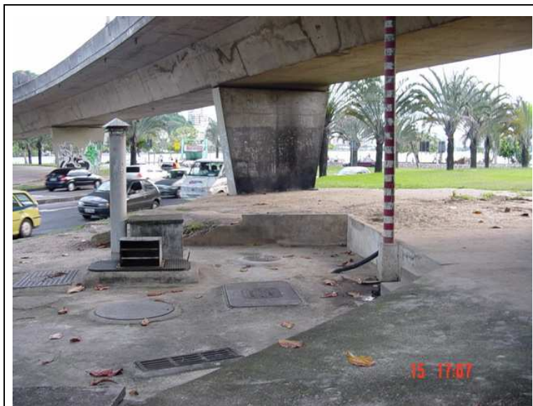
Figura 3.6. Vista do local onde está situado o poço de sucção da Elevatória José Mariano – EE-17.
