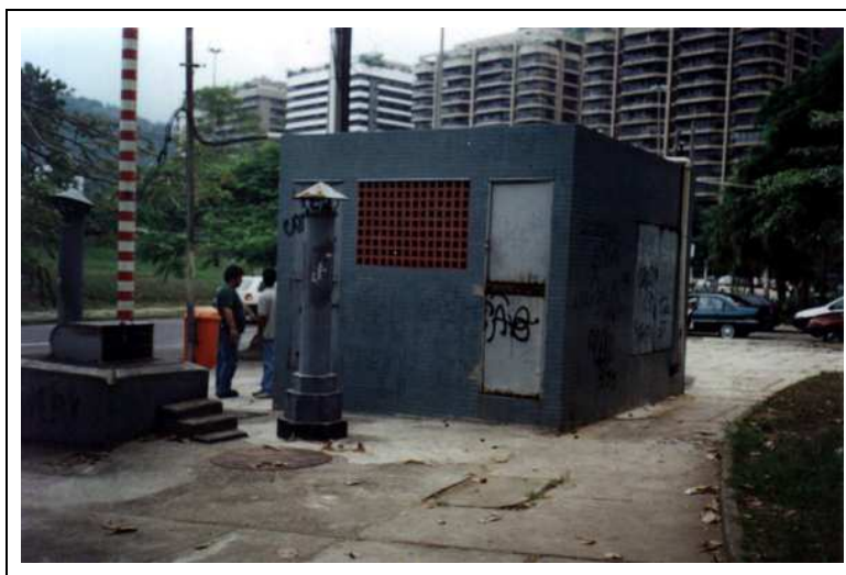
Figura 3.5. Vista da Casa de Operação e da Régua de Controle do Poço de Sucção da Elevatória Cantagalo – EE-14.
