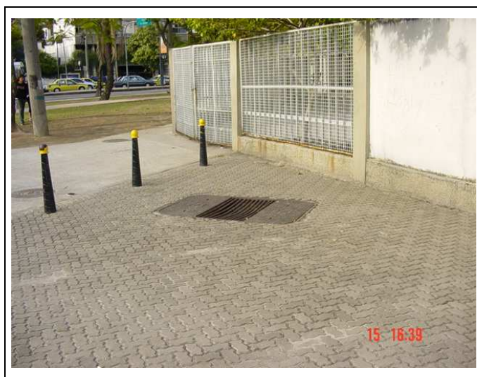
Figura 5.5: Vista do tampão que encobre a captação de tempo seco, situada na rua Frei Veloso.
