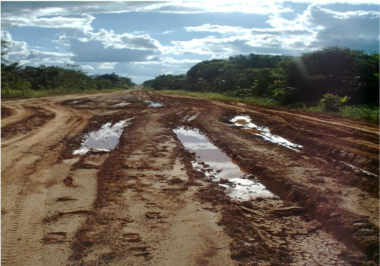
**Fig. 8** Rodovia BR-230 – Transamazônica (AM), totalmente deteriorada pela ausência de manutenção. Fonte: DNIT (2003).
