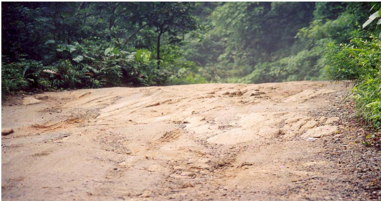
**Fig. 4** Leito estradal da RJ-165 – “Paraty-Cunha”, totalmente deteriorado, no interior do PNSB. Foto de Regina Avena e Carlos Saldanha - 2003
