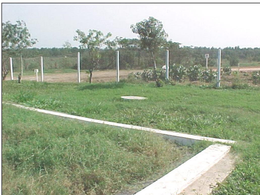
**Figura 4.11 – Saída do *wetland* plantado com gramínea e entrada da área de irrigação**
