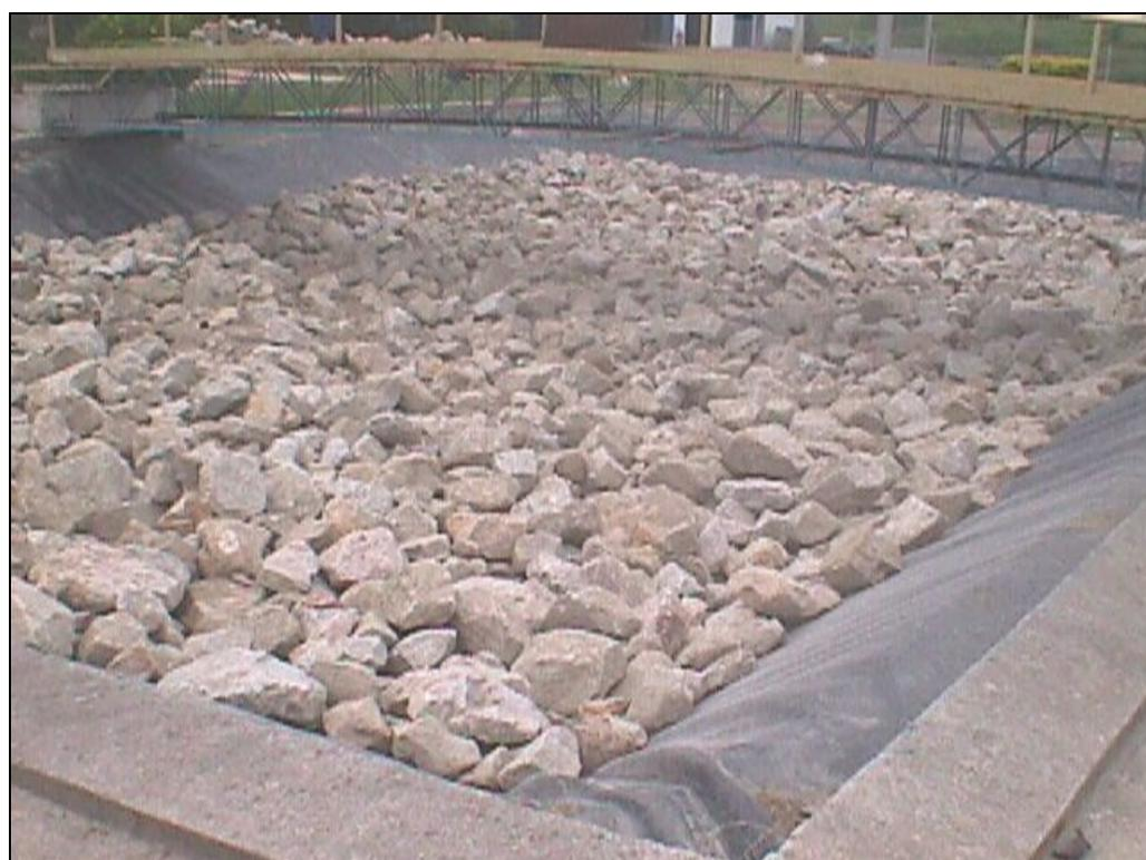
**Figura 3.2 – Rachão espalhado no fundo do tanque**
