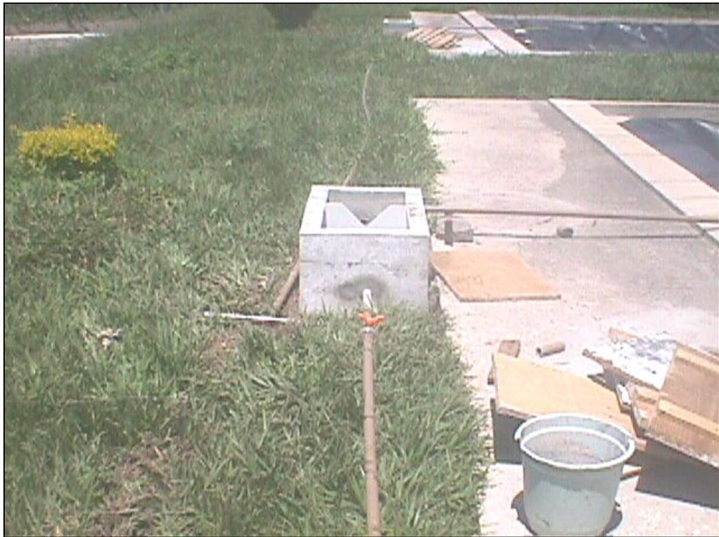
**Figura 3.12 – Caixa de passagem para controle da vazão de alimentação de um *wetland*, precedida de registro de esfera em PVC**
