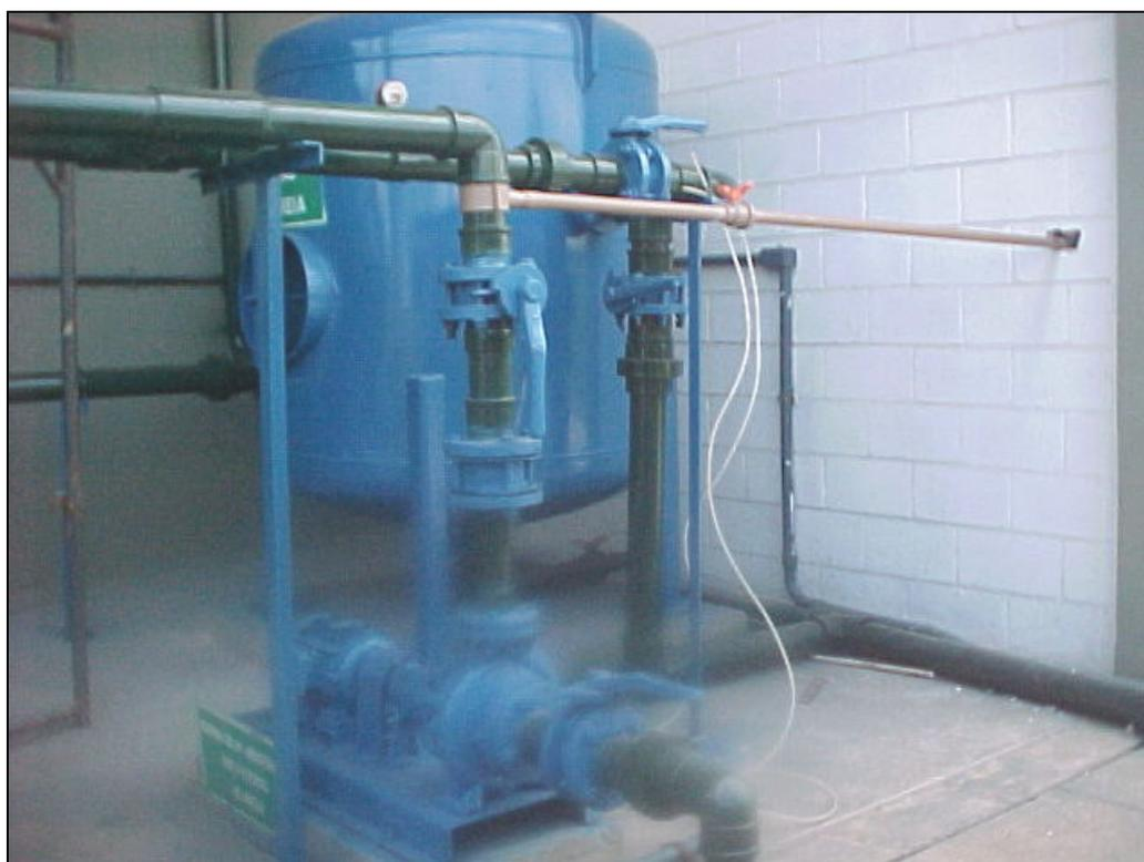
**Figura 3.10 – Derivação na tubulação após a bomba do filtro de areia**
