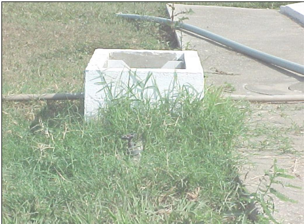
**Figura 3.13 – Caixa de passagem para controle da vazão de alimentação de um *wetland*, precedida de registro de gaveta em metal**
