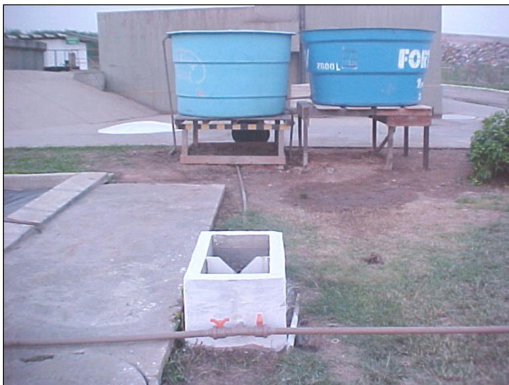
**Figura 3.14 – Saídas de uma caixa de passagem em direção ao *wetland* e ao talude**
