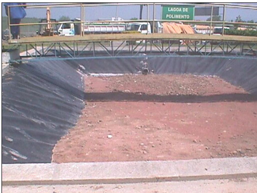
**Figura 3.1 – Tanque com geomembrana de PEAD e argila**
