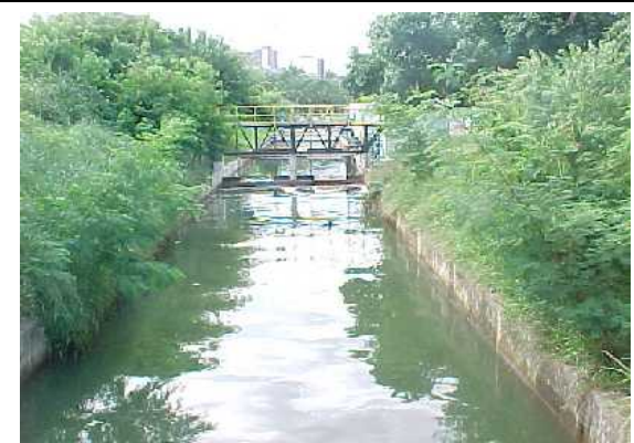
(j) Estação de despoluição na galeria de
