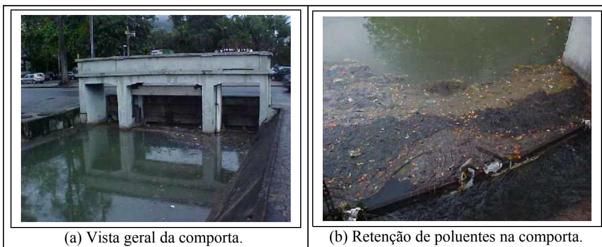
Figura 50. Comporta do canal da rua General Garzon (Fotos: Dias, A.P. julho 2003).
