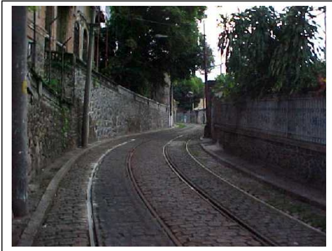
Figura 9. Trecho final da rua Joaquim Murтинho próximo aos arcos (Fotos: Dias, A.P. fev. 2002).
