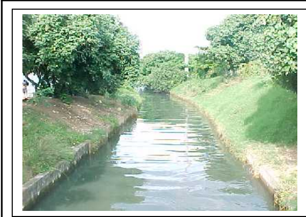
(k) Trecho final da galeria de cintura.
