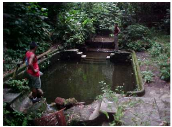
(b) Primeira represa de controle de vazão.
