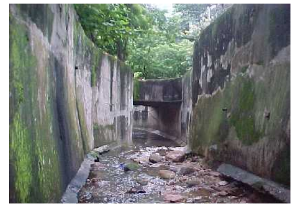
(h) Passagem para revestimento em concreto.
