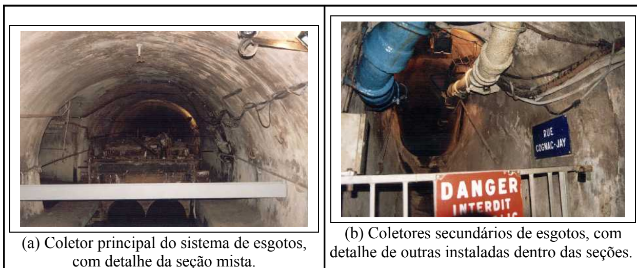
Figura 21. Aspectos do sistema de esgotos “ tout-à-l’égout ” (Fotos: Gandhi Giordano, 1998).
