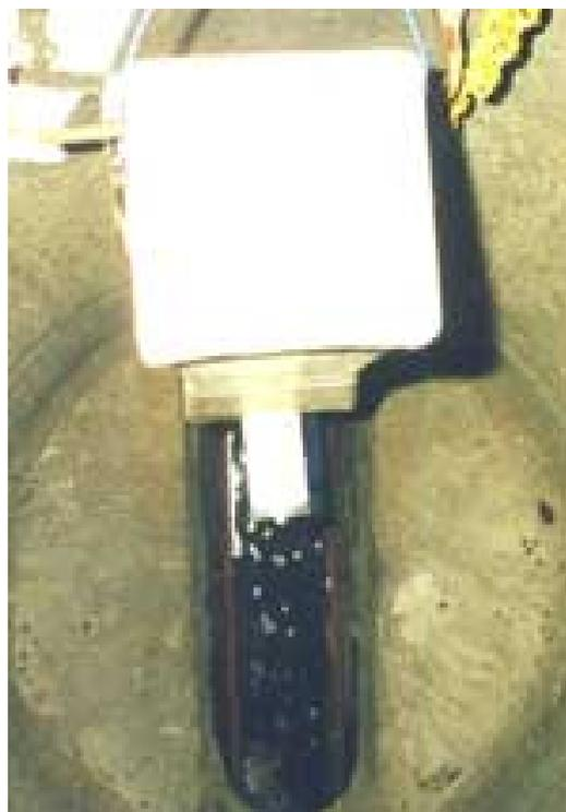
**Figura 2.4** – Dosador automático de produtos biológicos diretamente na rede coletora.
