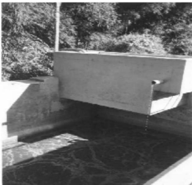
**Figura 7.IV.14** – Caixa de gordura utilizada antes da Estação de Tratamento de Esgotos do Hotel – Angra dos Reis – RJ.
