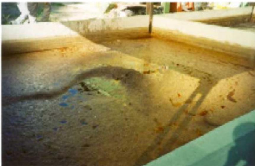
**Figura 7.IV.16** – Leito de secagem com gordura retirada da caixa de gordura de “polimento”
