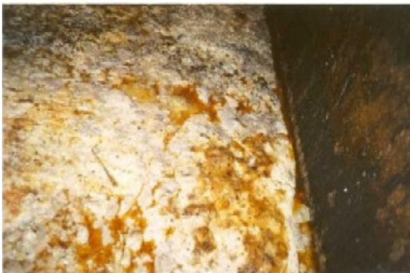
**Figura 7.IV.17** – Caixa de gordura principal – Vista superior antes da limpeza mecânica e do início do tratamento enzimático/biológico – Hotel em Angra dos Reis - RJ.
