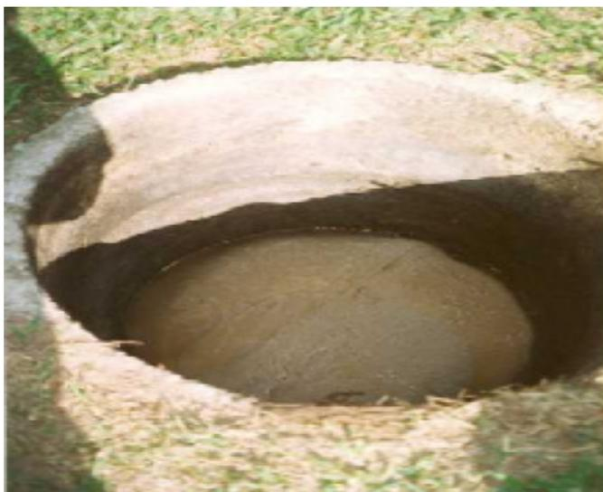
**Figura 7.IV.18** – Caixa de passagem a jusante a caixa de gordura principal, após o início do tratamento enzimático/biológico – Hotel em Angra dos Reis – RJ.
