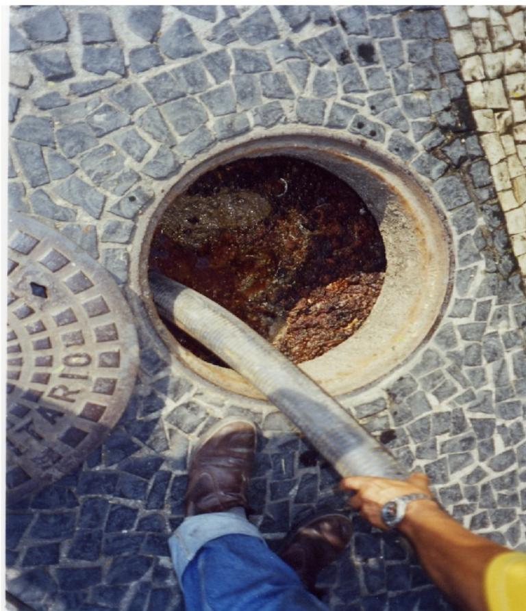
**Figura 2.6** – Gordura acumulada em caixa de gordura, proveniente de restaurantes de Shopping Center (RJ), sendo removida por sucção para um caminhão tipo “limpa-fossas”.
