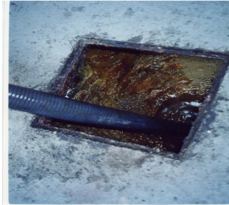
**Figura 2.7** – Gordura depositada em caixa de gordura.
