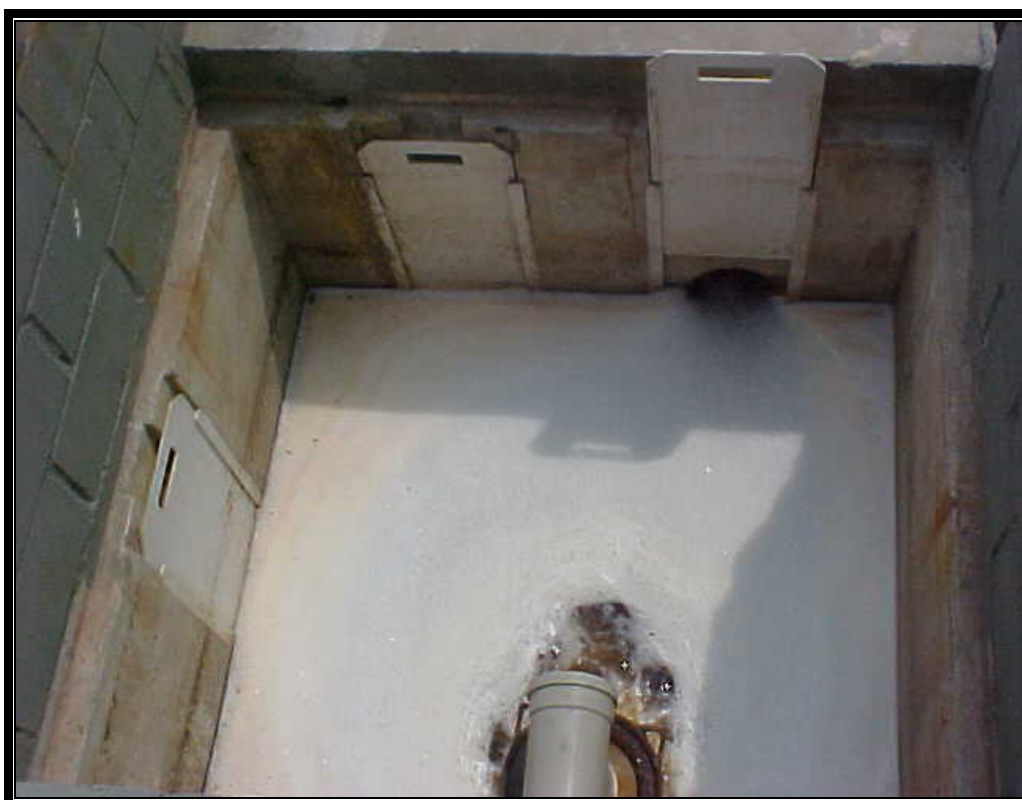
Foto 14 Poço de sucção.
