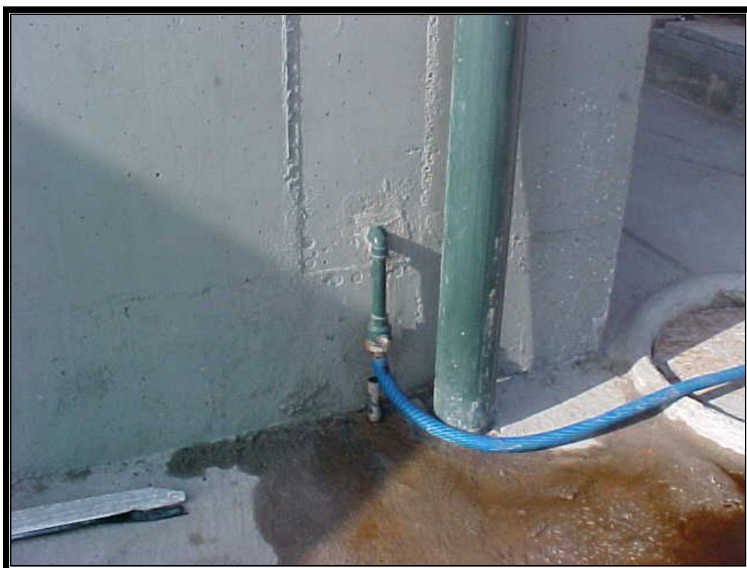
Foto 38 Substituição da tubulação de PVC.
