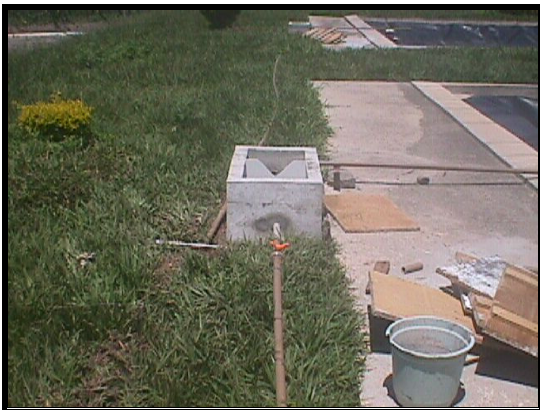
Foto 27 Caixa medidora de vazão.
