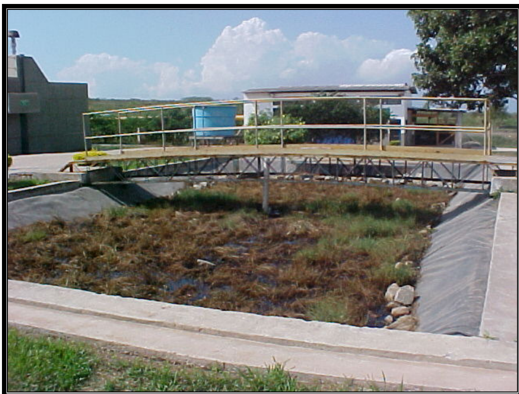
Foto 35 Plantio do capim no “Wetland”.
