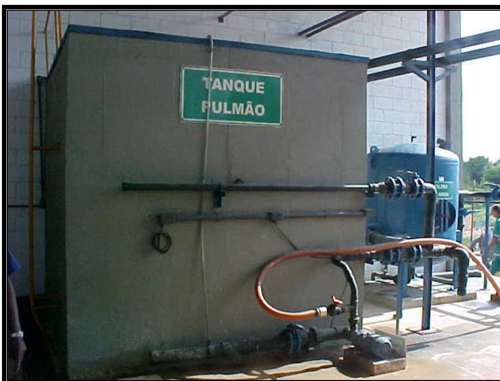
Foto 16 Tanque pulmão.
