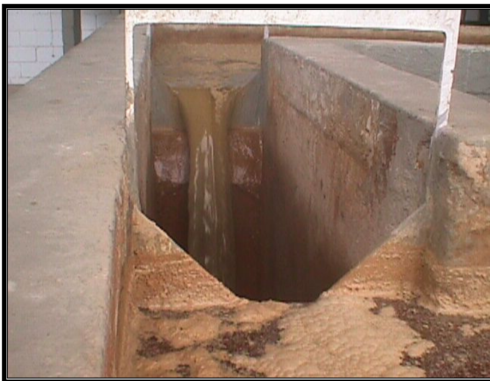
foto 9 Calhas de pré-sedimentação com medidor de vazão.
