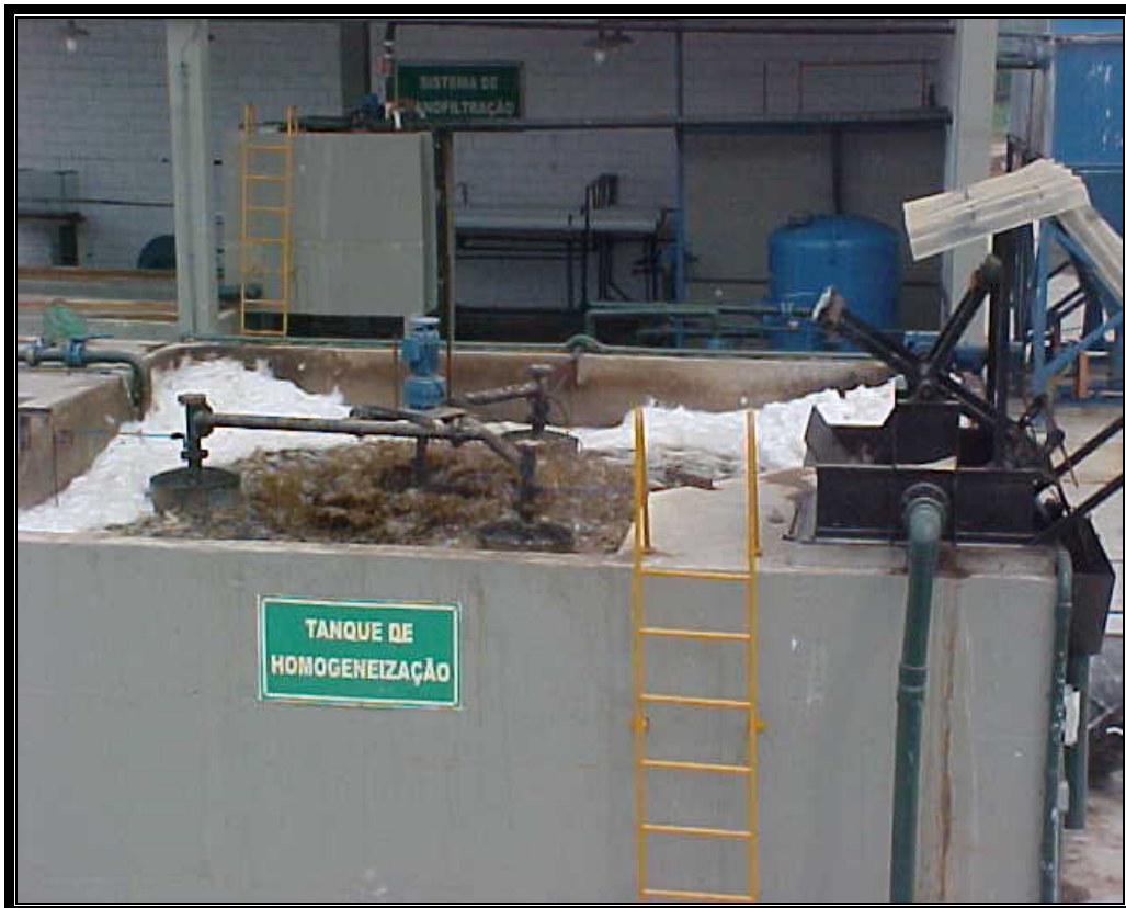
Foto 6 Tanque de homogeneização
