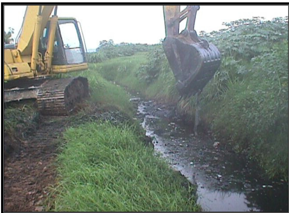
Foto 4 Limpeza da vala de coleta do chorume.
