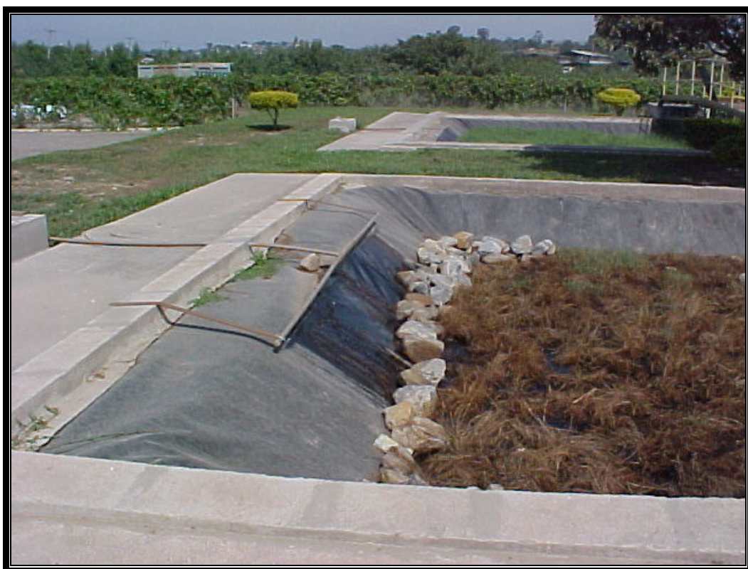
Foto 36 Descarga de chorume no “Wetland”.
