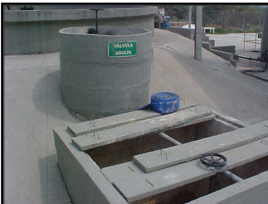
Foto 20 Poço de lodo.
