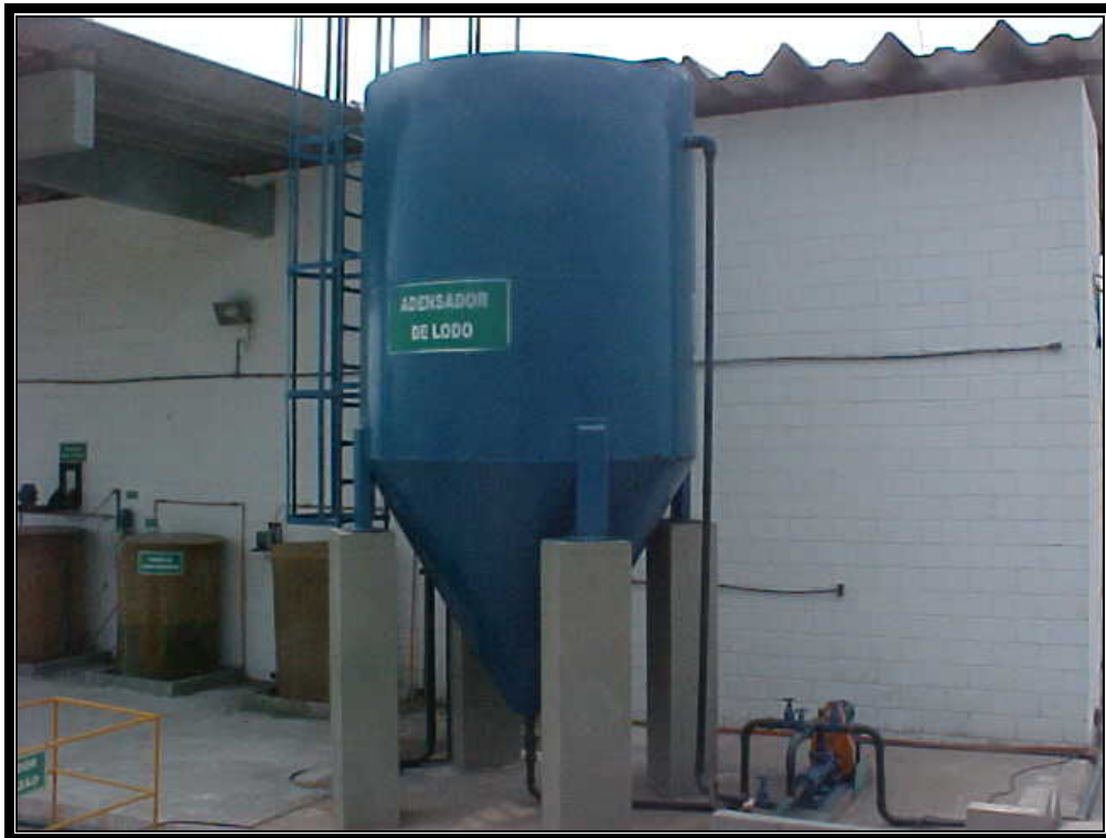
Foto 21 Adensador do lodo.
