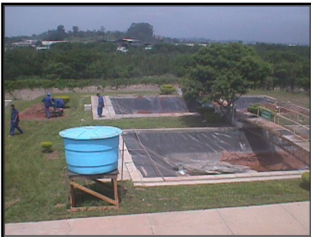
Foto 26 Caixa de acumulação de chorume.
