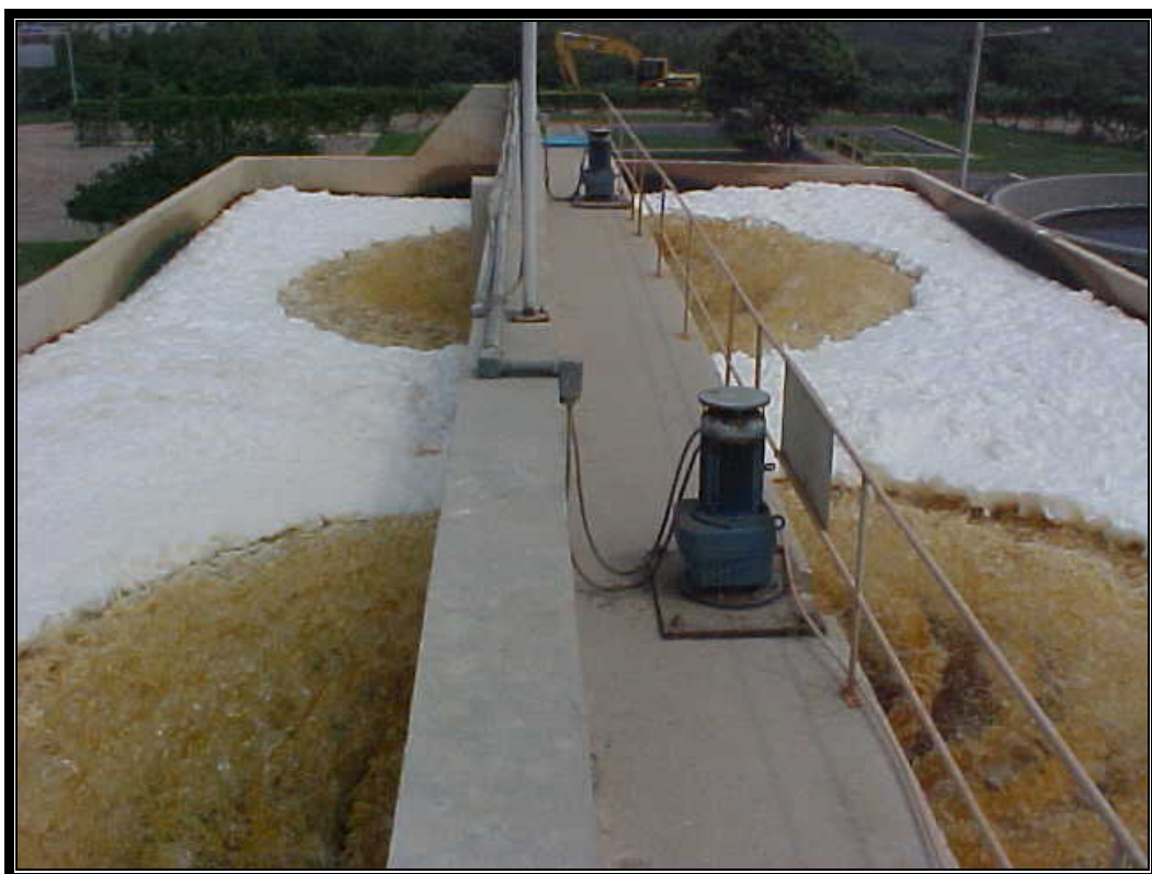
Foto 11 Tanque de aeração.
