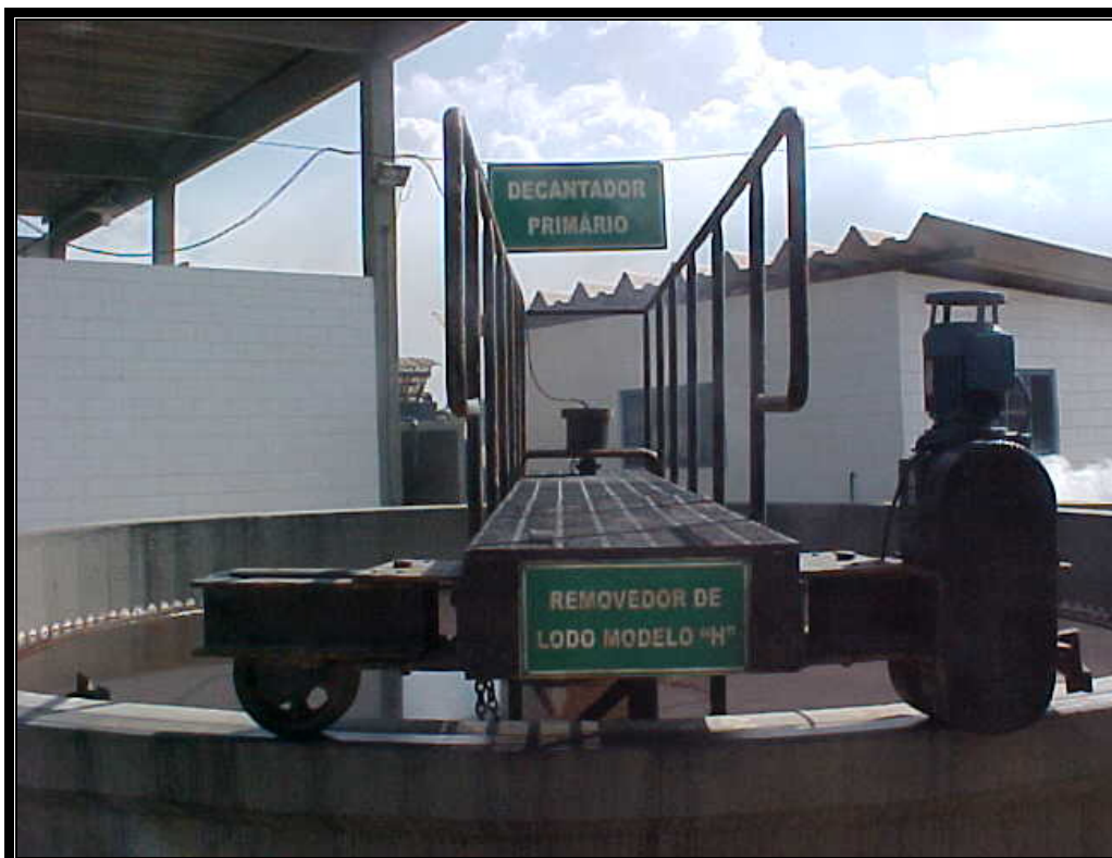
Foto 10 Decantador primário.
