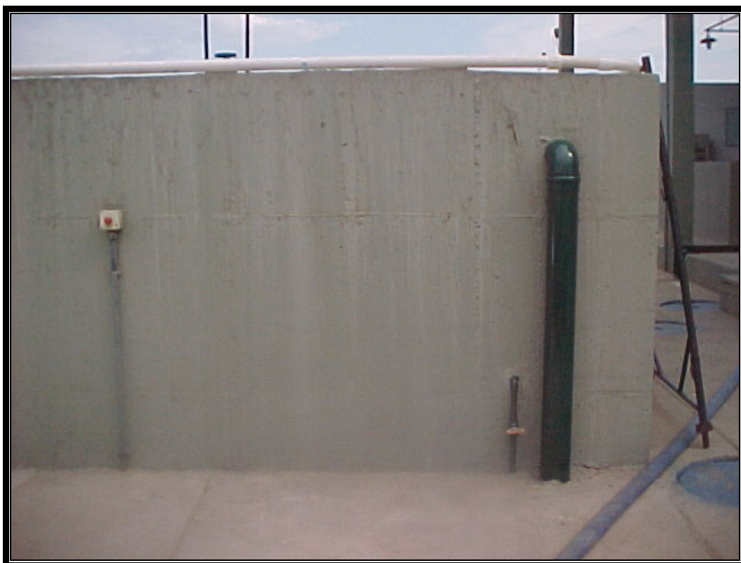
foto 23 Saída do tanque de homogeneização.
