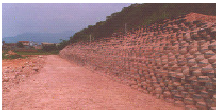
Figura 5 - Exemplo de utilização na contenção de encostas Fonte – Gerscovich (2000)
